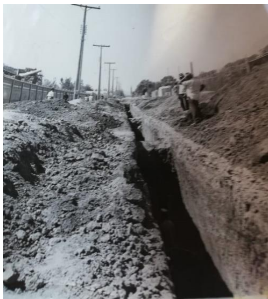
Esta foto corresponde a la construcción de la red de alcantarillado de la Villa Macul. Foto 16
